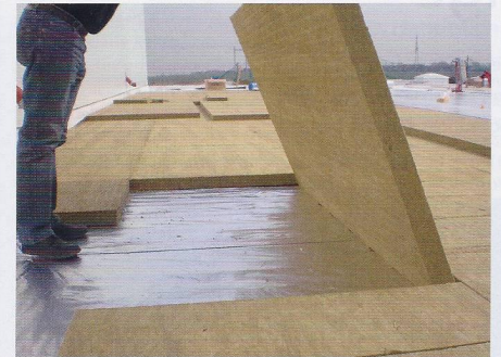
Verlegung der Dampfsperre mit Nahtverklebung unterhalb der Wärmedämmung.
