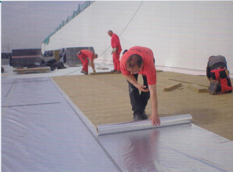
Verlegung der Dampfsperre mit Nahtverklebung unterhalb der Wärmedämmung.
