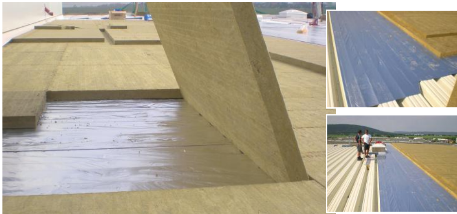
Die vollflächige Verlegung der Dampfsperre mit Nahtverklebung unterhalb der Wärmedämmung verhindert die Schädigung von Dach und Gebäude durch Kondenswasserbildung.
